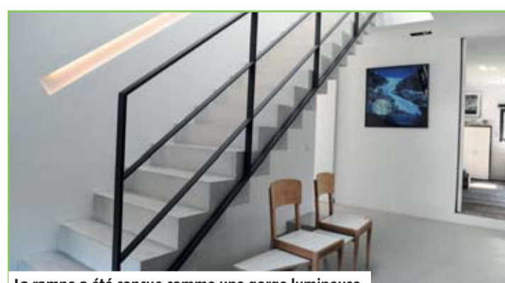
La rampe a été conçue comme une gorge lumineuse.
